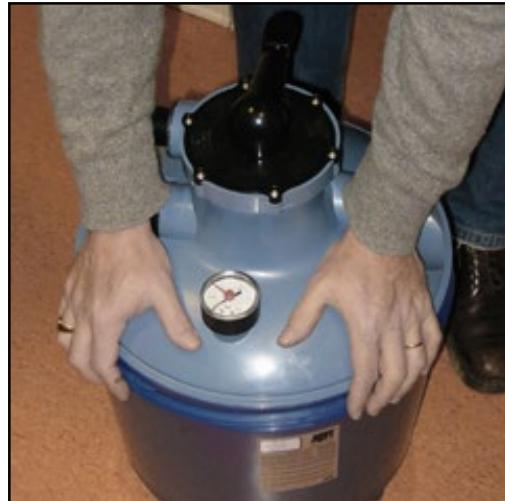
Pousser simultanément sur les deux mains pour emboîter complètement le couvercle. Conserver la pression sur le couvercle jusqu'à la mise en place de l'anneau de ceinture.
