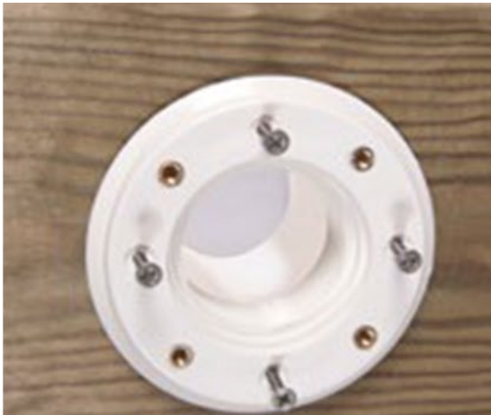
Abbildung 24 – Montage der Wanddurchführung für Einlaufdüse
