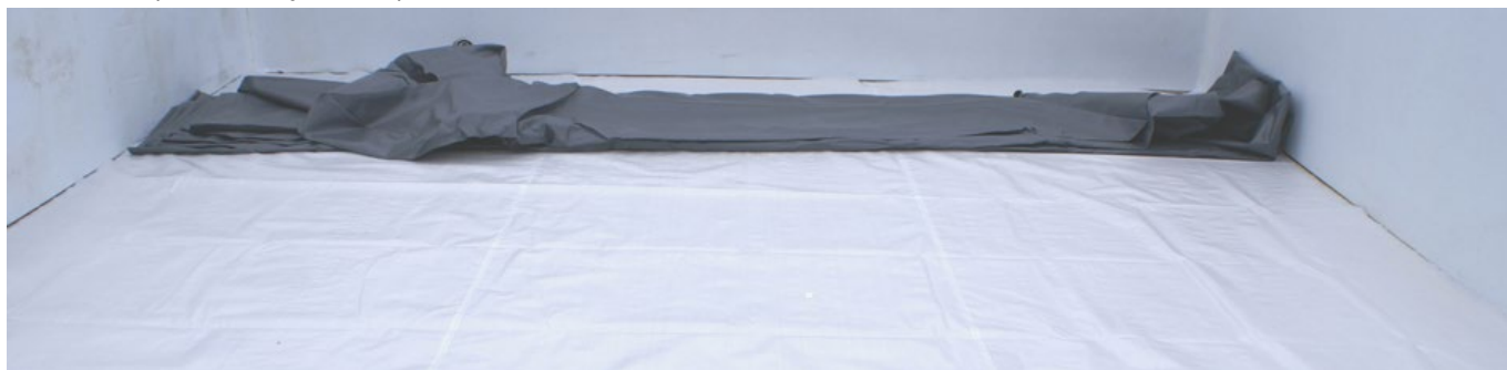
Figura 27 – Despliegue del revestimiento
