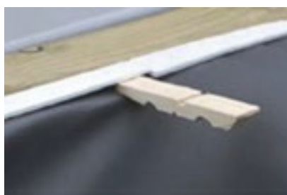
Figura 28 – Bloqueo del revestimiento con pinzas de la ropa
