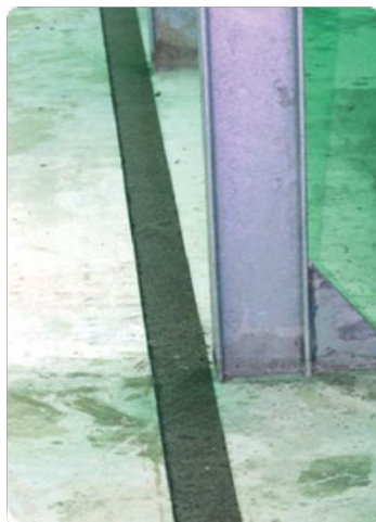
Figura 7 – Instalación de las bandas bituminosas
