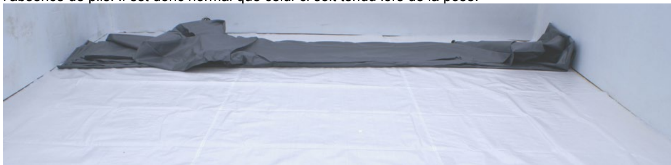
Figure 34 – Dépliage du liner
