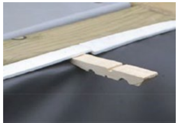
Abbildung 34 – Verlegung der Folienauskleidung mithilfe der halben Wäscheklammern
