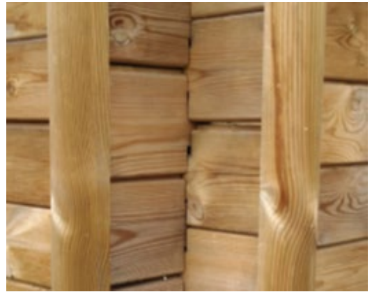
Abbildung 63 – Ineinanderfügen der Holzbohlen
