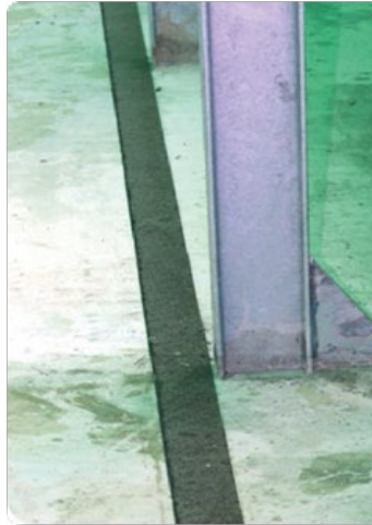
Abbildung 9 – Anbringen der Bitumenstreifen
