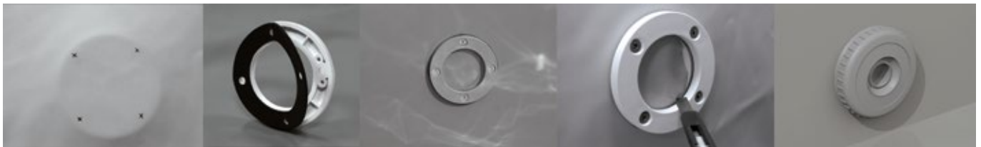
Figura 36 – Montaje de la brida sobre el retorno*
