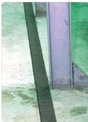
Figura 9 – Instalación de tiras bituminosas
