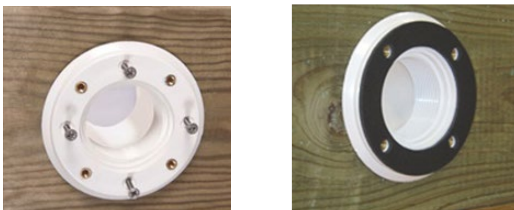
Figura 26 – Montaje del cuerpo de la boquilla de retorno y su junta
