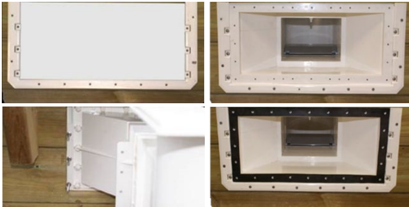
Figura 24 – Montaje del skimmer
