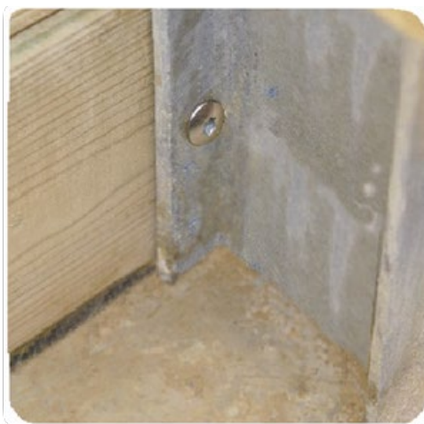
Figura 13 – Bloqueo de tablonos en los puntales
