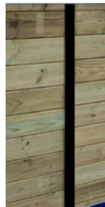
Figura 22 – Adesivo di protezione
