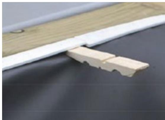
Figura 33 – Blocco del liner mediante semi-mollette per bucato
