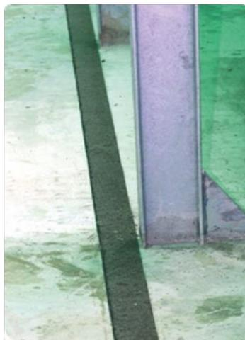
Figura 9 – Posizionamento delle bande bituminose
