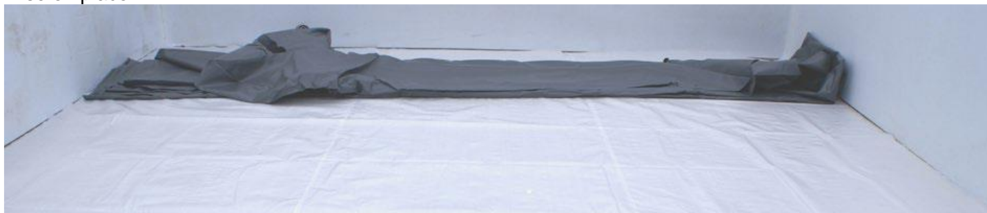
Figure 21 – Dépliage du liner
