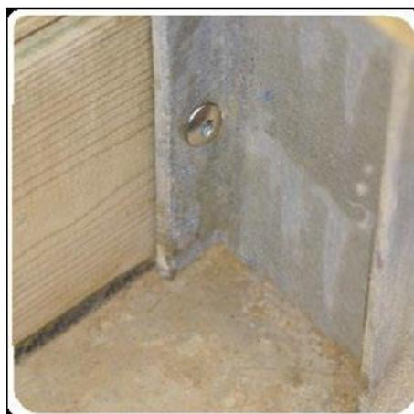
Abbildung 8 – Verschraubung der Bohlen auf den Streben
