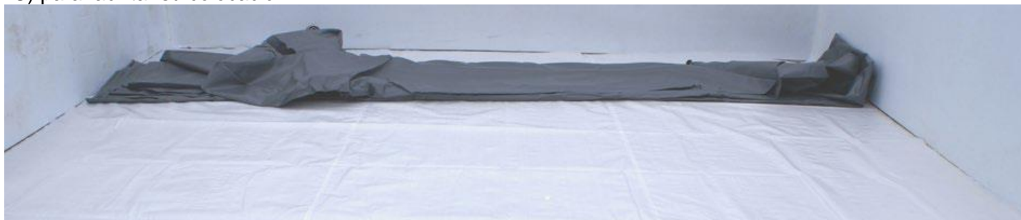
Figura 21 – Despliegue del revestimiento
