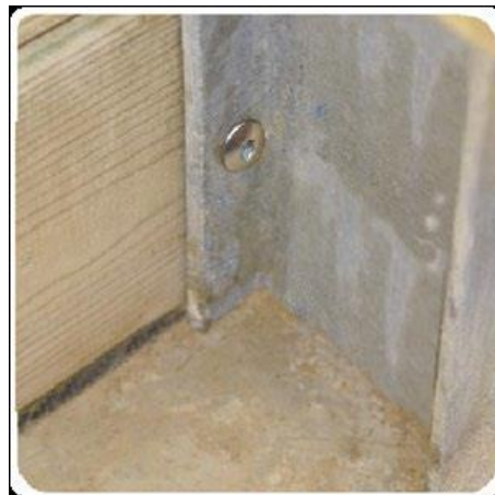
Figura 8 – Bloqueo de los tablonos en los puntales metalicos
