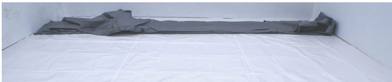
Figure 33 – Dépliage du liner
