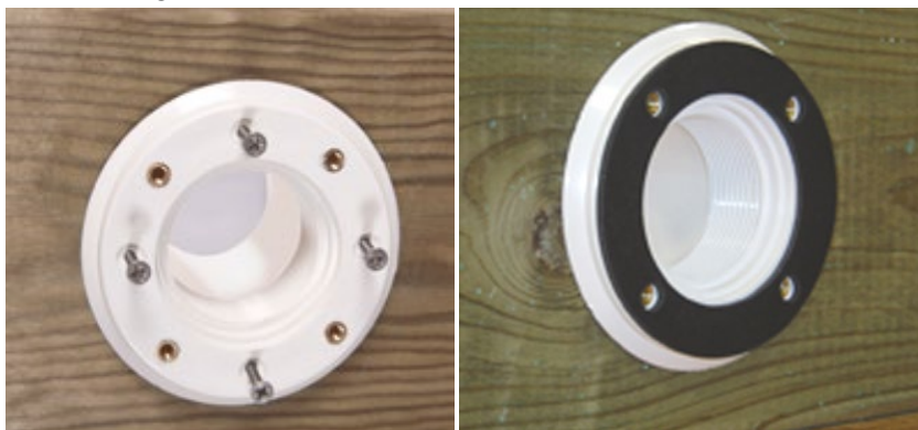
Abbildung 24 – Montage der Ausstoßdüse und seiner Dichtung
