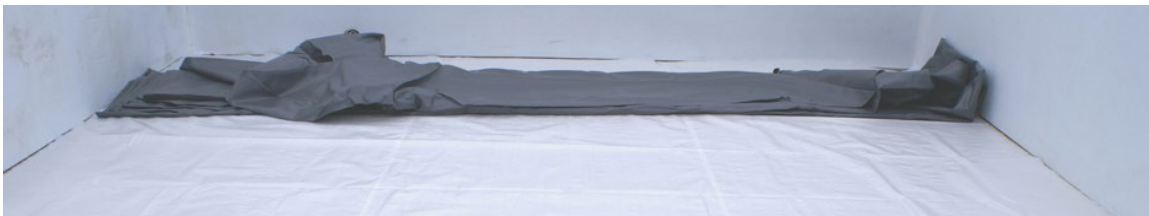
Abbildung 33 – Entfalten der Folienauskleidung
