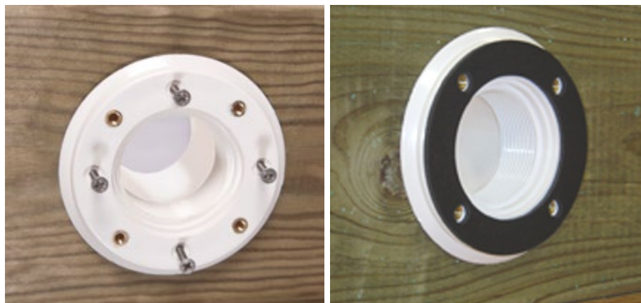
Figure 24 – Montaje del cuerpo de la boquilla de retorno y su junta
