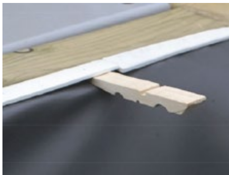
Figure 32 – Bloqueo del liner con pinzas de la ropa
