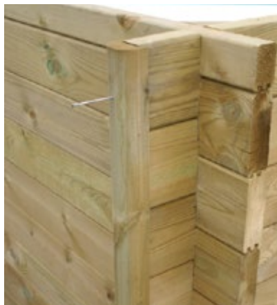
Figuur 20 – Houten afwerklijst
