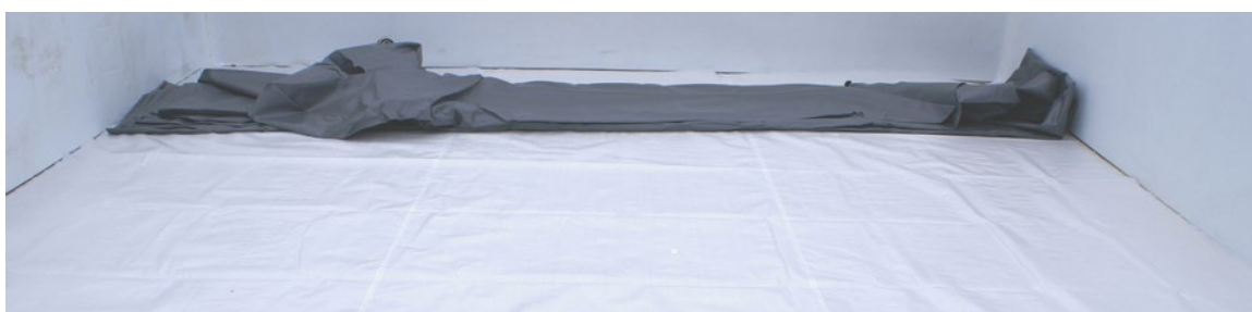
Abbildung 33 – Entfalten der Folienauskleidung
