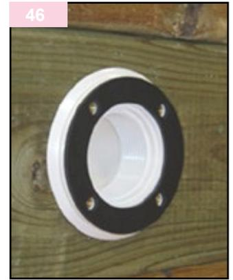
Coloque, al lado de la piscina, el cuerpo del tubo (pack de piezas para sellar) común al retorno en el orificio de la pared fabricada. Fíjelo con los tornillos VB FZ 3x25. Coloque una 1ª junta autoadhesiva en cada travesaño de pared. Realice un atornillado moderado para evitar partir el cuerpo del tubo. Es preferible finalizar el atornillado a mano.
