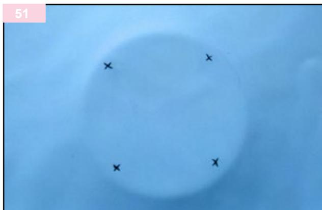
Localice a través del liner los cuatro puntos de atornillado del cuerpo del tubo.
