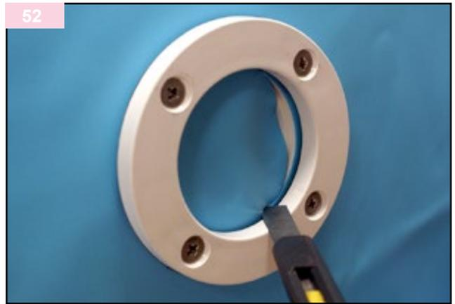
Effettuare l'apertura dell'ugello di mandata. Con l'aiuto di un cutter, tagliare accuratamente il liner appoggiandosi all'interno del corpo dell'ugello.
