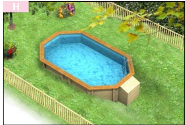
Effettuare il riempimento attorno al bacino evitando bruschi apporti di terra che potrebbero provocare deformazioni della struttura.
