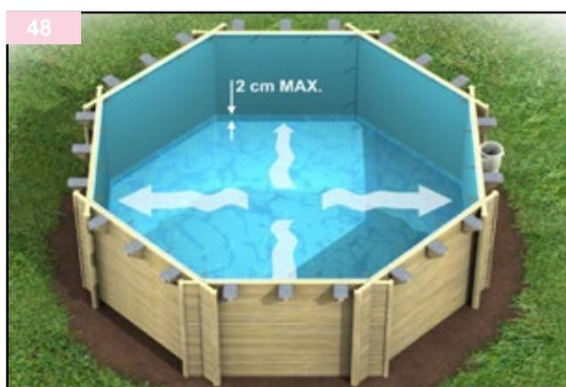
Quando il liner è perfettamente fissato e in posizione, riempire la piscina con solo 2 centimetri di acqua. Spingere al massimo le pieghe del liner dal centro verso le pareti.
