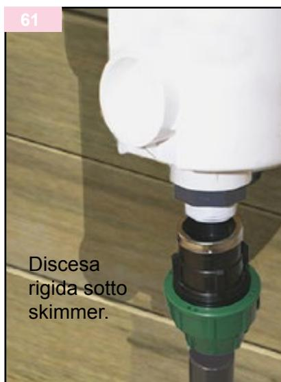
Avvitare sotto lo skimmer il raccordo J senza dimenticare di applicare il teflon sulle 2 filettature.
