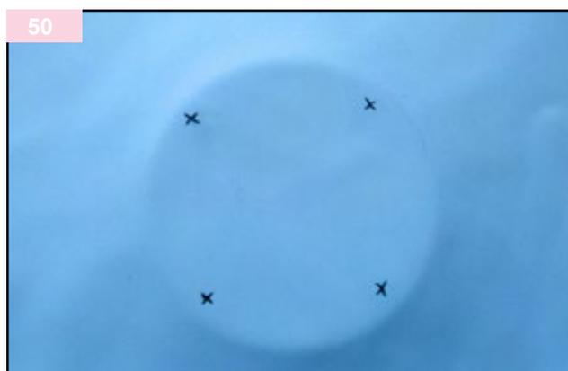
Individuare attraverso il liner i quattro punti di avvitamento del corpo dell'ugello.
