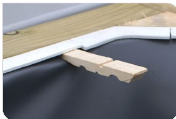
Figure 40 – Fixage du corps de buse
