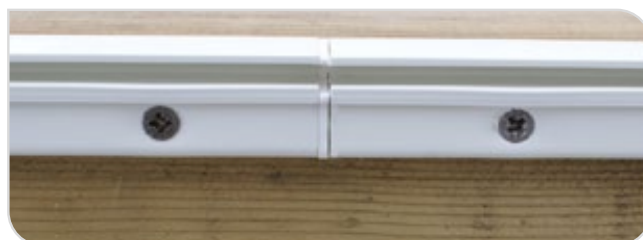
Figure 29 – Jonction des rails
