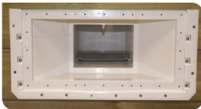
Figure 33 – Mettez en place le skimmer
