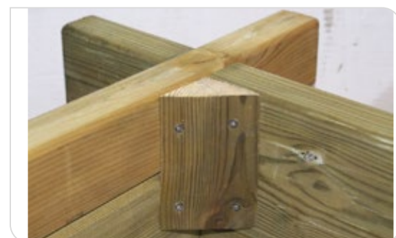
Figure 26 – Pièce de bois dans un angle
