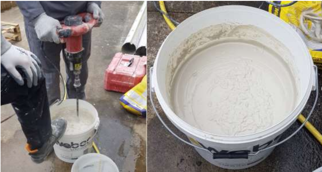
Abbildung 60: Dichtmasse mischen
