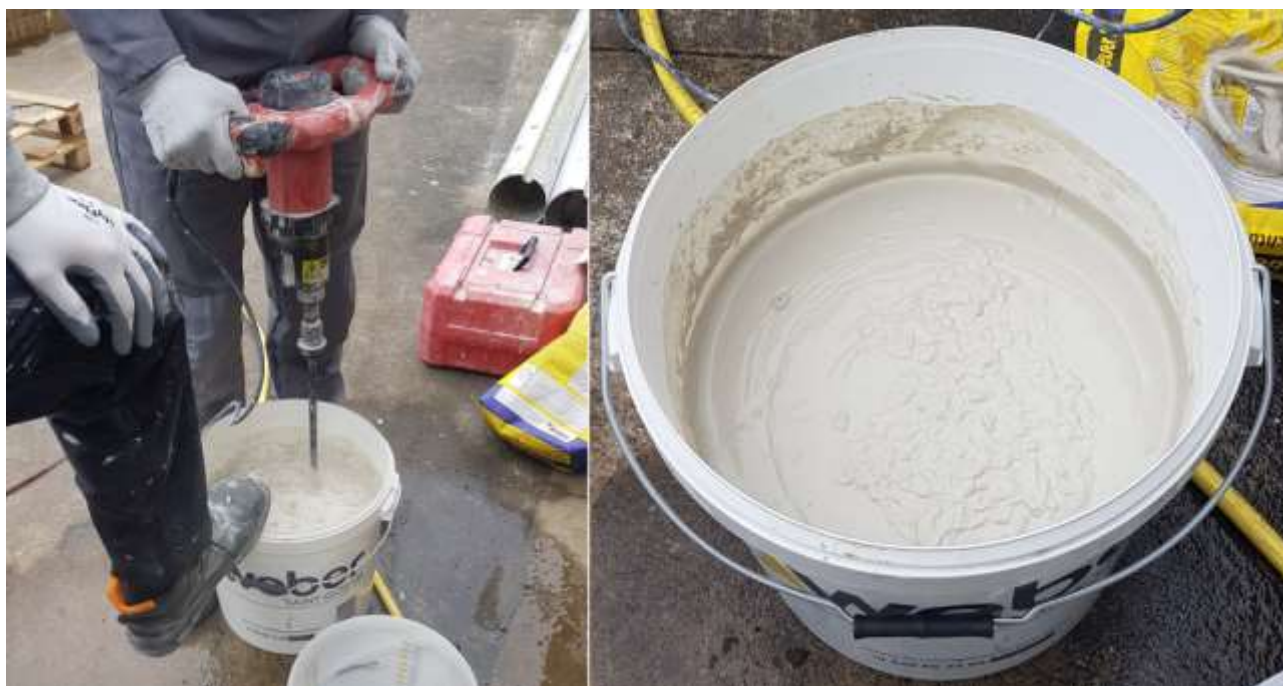
Figure 12 : Mélange d'enduit d'étanchéité
